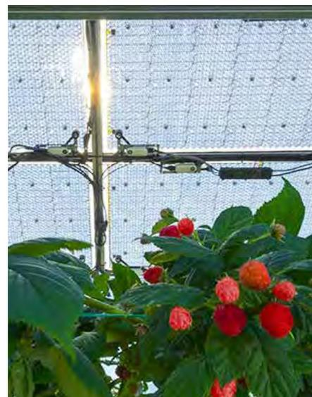
Parce qu'ils sont perméables à la lumière, les modules peuvent être utilisés au-dessus des surfaces agricoles.
