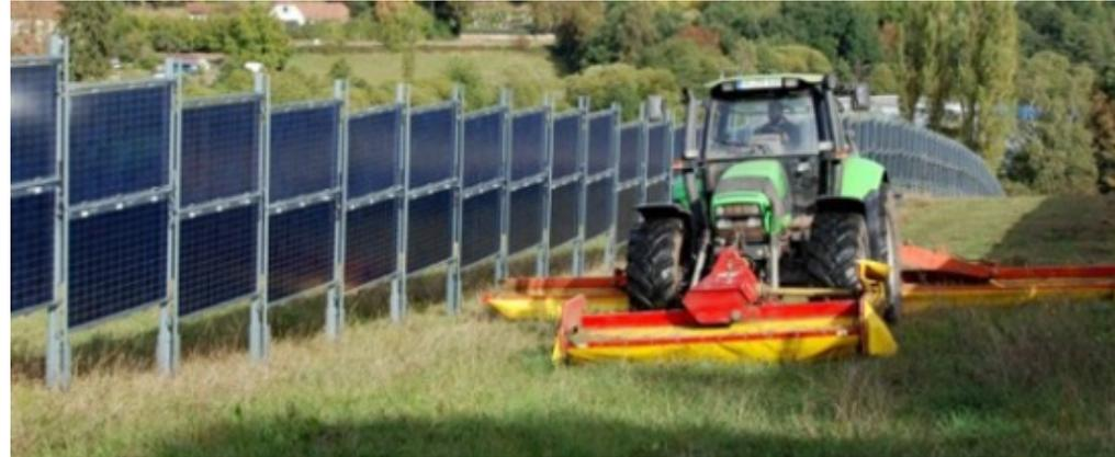
Système PV mural ou de clôture équipé de modules bifaciaux. L'espacement des rangées peut être adapté
