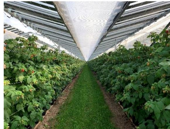
Cette installation Agri-PV est orientée **est-ouest** et convient parfaitement à une utilisation avec des cultures en lignes.
