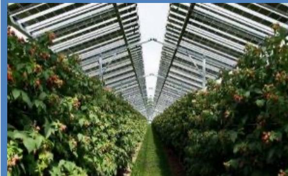
**Dauerkulturen:** Anlagen mit semitransparenten Modulen Nennleistung: 737 kWp/ha. Spezifischen Jahresleistung von 1170 kWh/kWp, **Flächenertrag von 862 MWh/ha/a.**
