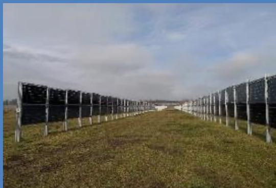
**Dauergrünland:** vertikale Module in Ost-West-Aufständigung, Nennleistung von 293 kWp/ha. Spezifische Jahresleistung: 1000 kWh/kWp, **Flächenertrag von 293 MWh/ha/a.**
