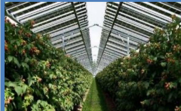
**Cultures pérennes** : installations avec modules semi-transparents. Puissance nominale : 737 kWp/ha. Puissance annuelle spécifique de 1170 kWh/kWp, **rendement de surface de 862 MWh/ha/a.**
