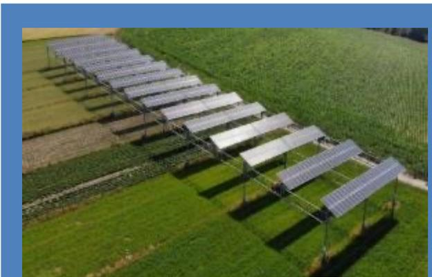
**Grandes cultures** : le rendement annuel est simulé avec un angle d'inclinaison fixe de 20° et une orientation de 30° sud-ouest avec des modules bifaciaux. Puissance nominale : 612 kWp, rendement annuel spécifique de 1200 kWh/kWp, **rendement de surface de 735 MWh/ha.**
