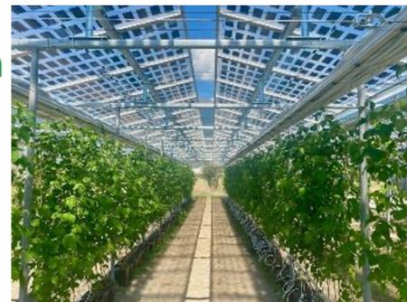
***insolagr*in** est un nouvel outil pour les agriculteurs. Il permet un ajustement dynamique de la lumière pour optimiser la croissance des cultures au fil des saisons. L'excédent de lumière solaire est transformé en électricité, ce qui permet une double utilisation des terres - sans compromis.
