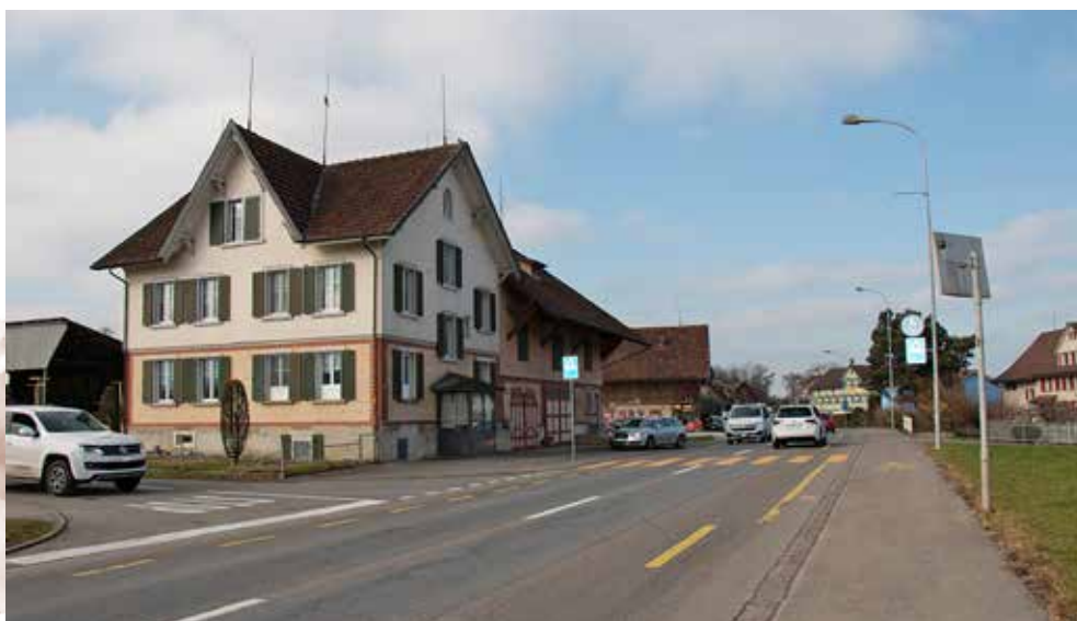
La route cantonale très fréquentée coupe la maison d'habitation et la grange de la pommeraie.
