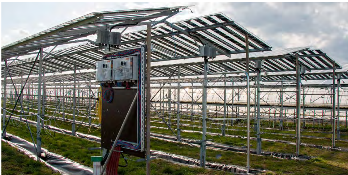
Auf 20 Aaren der Betriebsfläche der Beerenland AG wachsen Erdbeeren und Himbeeren unter Solarpanels. Die produzierte Energie wird direkt ins Eigenverbrauchsnetz eingespeist.
