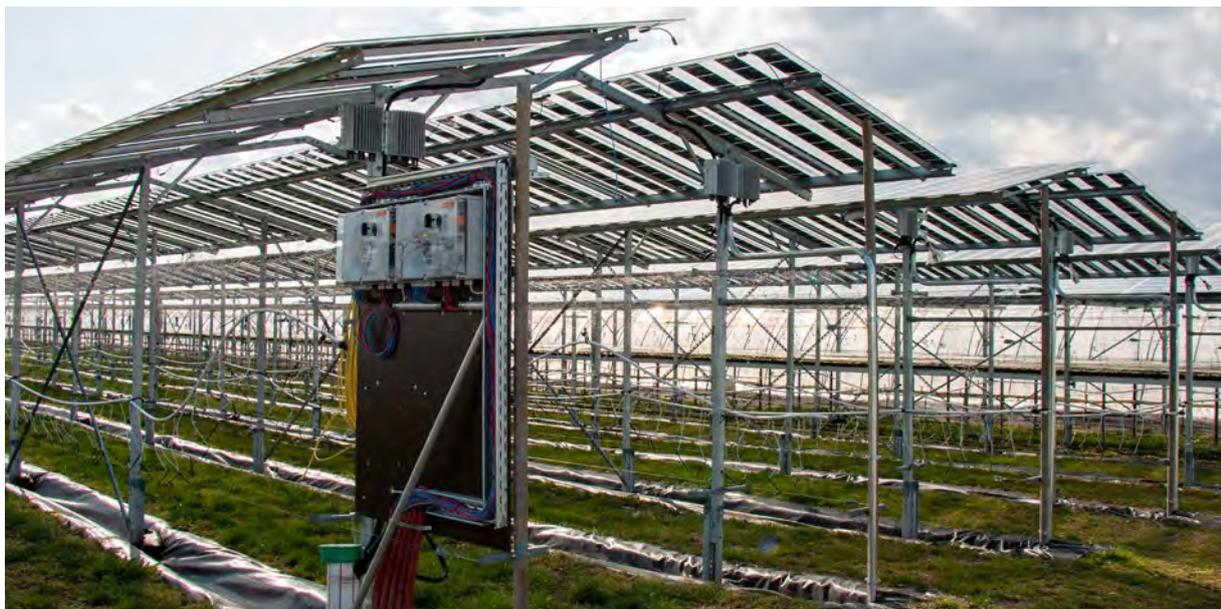
Des fraisiers et des framboisiers poussent sur 20 ares de la surface exploitée par Beerenland AG sous des panneaux solaires. L'énergie produite est injectée directement dans le réseau de consommation.
