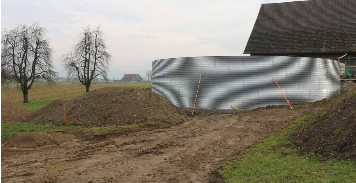
Das Wassersilo fasst 1000 Kubikmeter Wasser.
