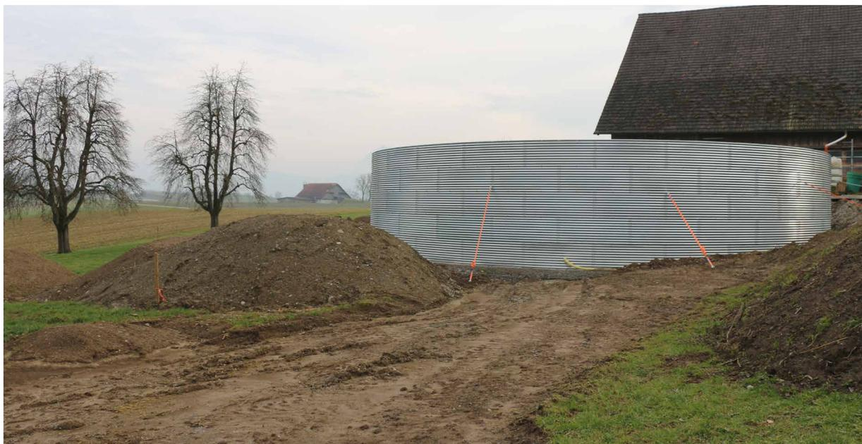
Le silo à eau a une capacité de 1000 mètres cubes d'eau.
