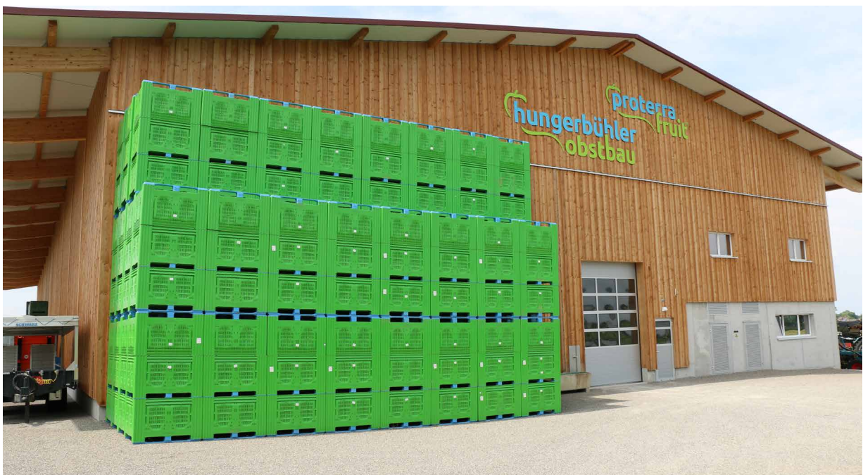
Die Kühllager in der neuen Lagerhalle fassen 2300 Tonnen Früchte.
